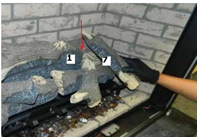
Schéma 13 - Installation de la bûche 7
