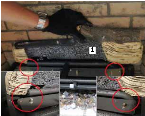
Schéma 7 - Installation de la bûche 1
