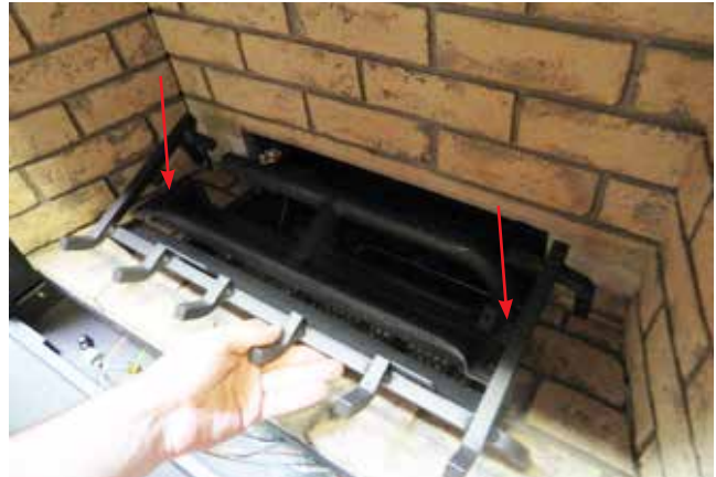
Schéma 2 - Installation du support de bûches
