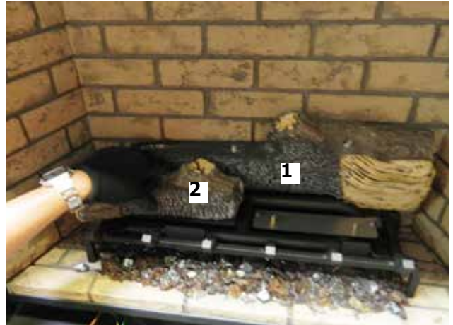
Schéma 8 - Installation de la bûche 2
