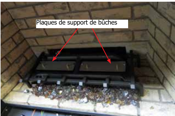
Schéma 6 - Plaques de support de bûches installées
