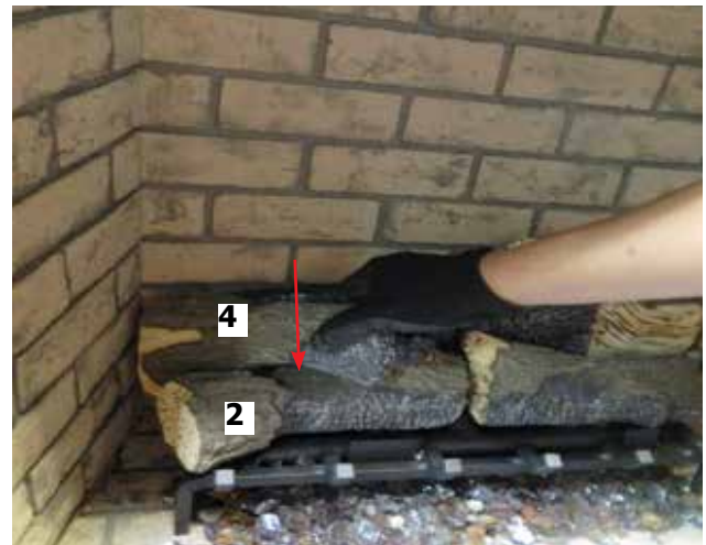
Schéma 10 - Installation de la bûche 4
